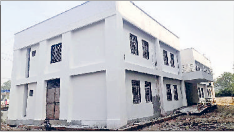
सोनीपत। बड़ी औद्योगिक क्षेत्र में निर्माणाधीन ईएसआई डिस्पेंसरी का भवन।
